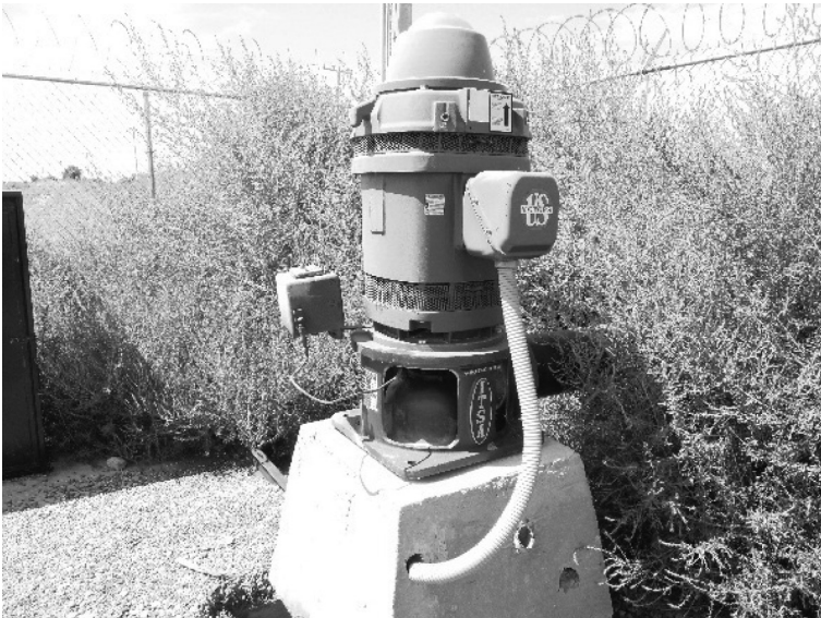
FIGURA 40. Fotografía del pozo PG-11 ubicado en Praxedis G. Guerrero.
